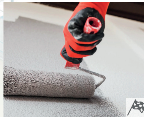
SCHILDERWERKEN TRAVAUX DE PEINTURE
