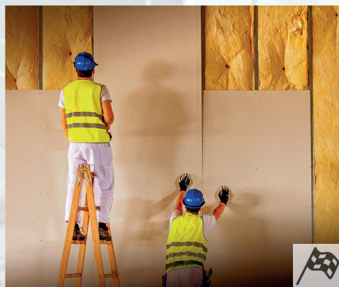
GIPSWERKEN TRAVAUX DE PLÂTRERIE
